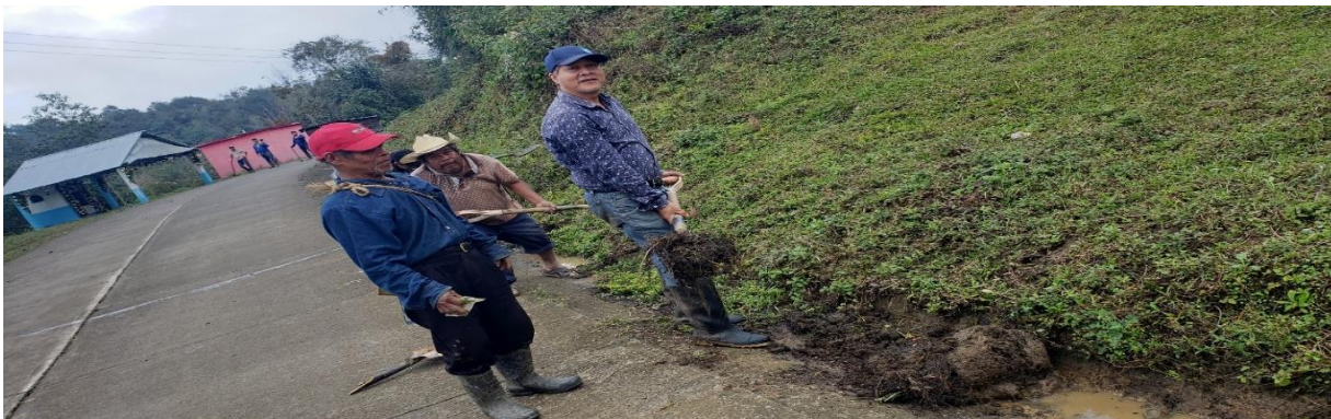
PARTICIPACION EN FAENA COMUNITARIA EN LA COMUNIDAD DE TECUEYACA, CALNALI, HGO. REALIZANDO LA LIMPIEZA DE CUNETAS.
