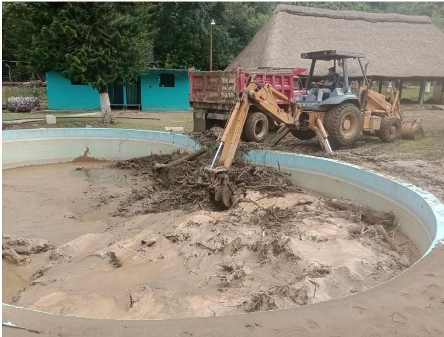
Apoyo con camión de volteo en retiro de material de escombros, en centro eco turístico Aguas Termales Atempa
